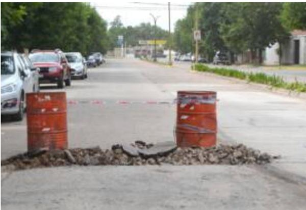
Hoy se levantó el pavimento deteriorado en la esquina de calle 44 bis y avenida 51, donde en las próximas horas se colocará la nueva capa de hormigón. También comenzó a realizarse la segunda etapa de arreglos en calle 60 y 55 y en 60 y 57.
