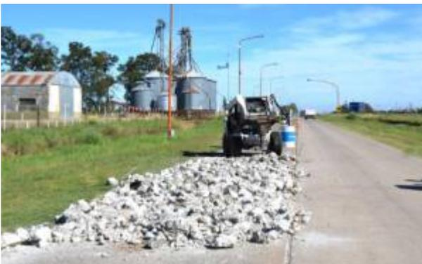
Hoy comenzaron a realizarse trabajos de bacheo en uno de los accesos a Villa Cañas, en inmediaciones a la estación de servicio Roselló. Como es habitual, se levantó el pavimento deteriorado y en las próximas horas se colocará la capa de hormigón correspondiente (15 metros lineales).
