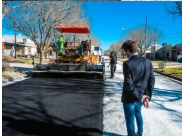
Por eso, se comenzó con el levantamiento de la superficie existente y la restitución de la base estabilizada, para luego ya con la calzada en condiciones aplicar el concreto asfáltico en caliente.
