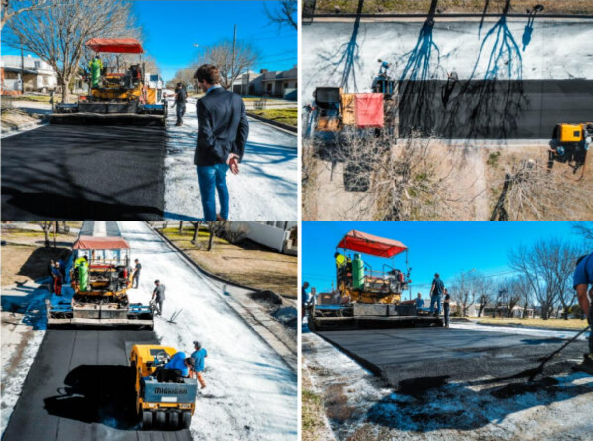
Dicho tramo había cumplido su vida útil y presentaba un avanzado estado de deterioro. Por eso, se comenzó con el levantamiento de la superficie existente y la restitución de la base estabilizada, para luego ya con la calzada en condiciones aplicar el concreto asfáltico en caliente. Con esta misma modalidad también se están interviniendo otras arterias de la localidad; como calle Simón de Iriondo entre Germana y Pedro Alonso y Gral. Urquiza.
