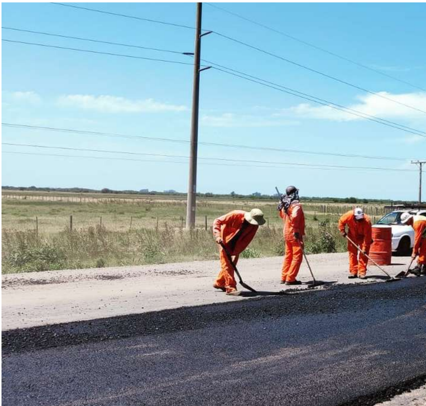
Las maquina trabajan a pleno para terminar los trabajos en un corto plazo.
