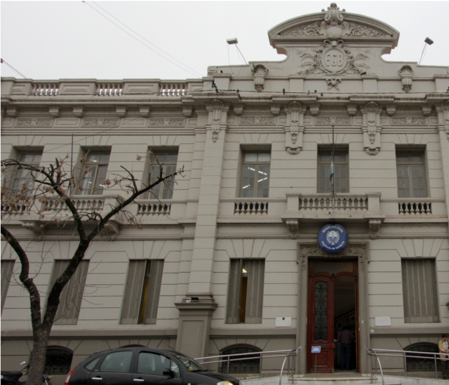
Registro Civil de la ciudad de Santa Fe
