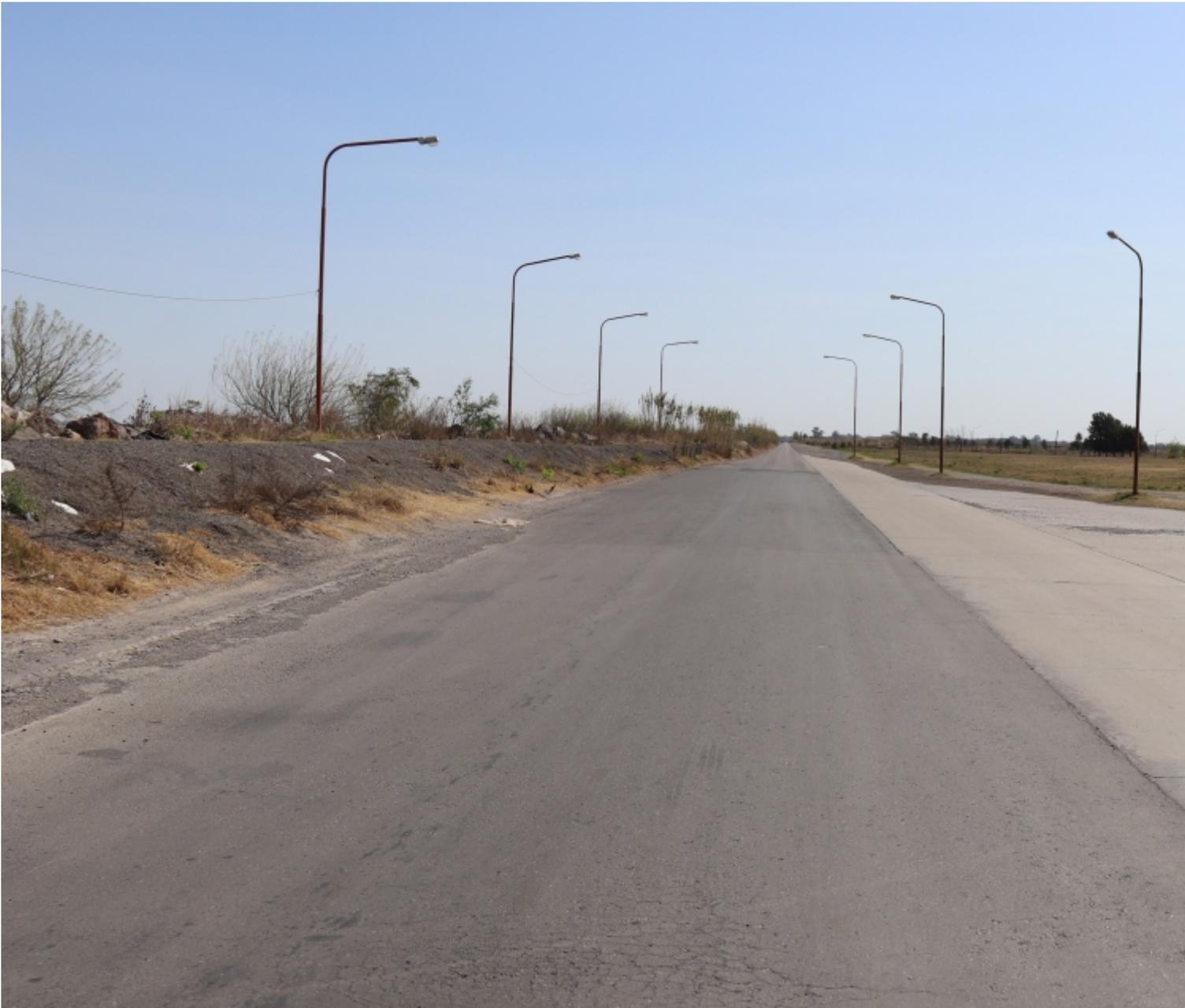
En el espacio, se plantea el reciclado con cemento en 35 centímetros de espesor, para la posterior construcción de una base de concreto asfáltico en caliente de 8 centímetros.
