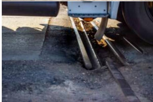
"El estado de este cruce es de completo deterioro, tiene importantes deformaciones, pavimento roto y resquebrajado en medio de los rieles, lo que deja expuestos a los conductores a situaciones peligrosas, rotura de vehículos, accidentes y además de que se ve afectado el flujo normal del tránsito debido a las largas filas de camiones y autos", comentó Enrico.
